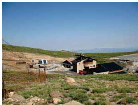
Fot. 3. Edificación central nueva destinada a hotel.
